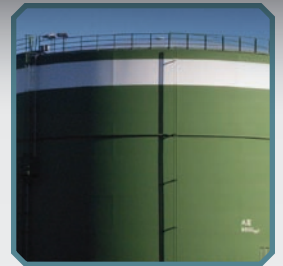
Topcoat over epoxy primer
