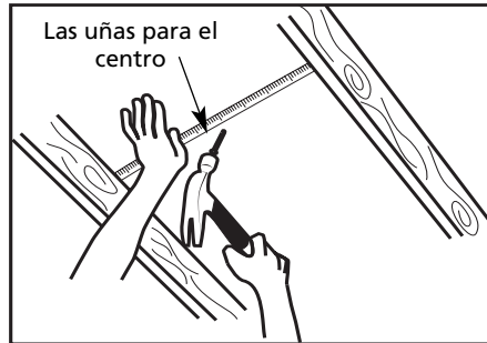
Figure 4 – Ponga un clavo que pasa por la placa del techo como un punto central
