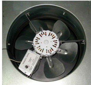
Figure 7 - La boîte de commande 10N201 a été montée sur la base.
