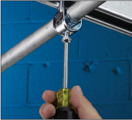
2. Tighten bolt.
