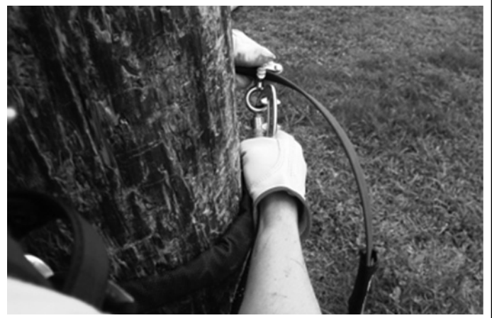
Figura 10 - Conexión al poste
